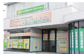
開所したながのPSセンターの外観
