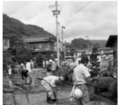
休みなく続く道路の泥除去作業
