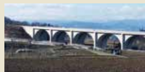
上田ローマン橋
